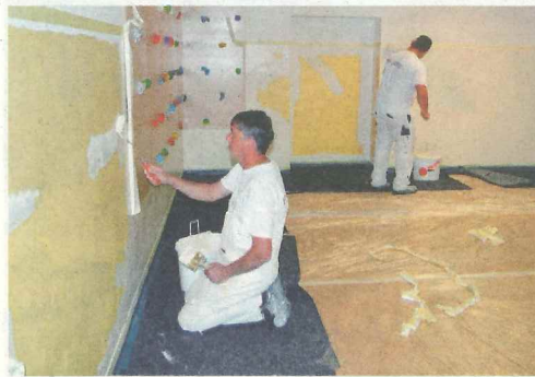
Im Kindergarten St. Marienheim von der Caritas benötigte der Turnsaal einen neuen Anstrich. Für frische Farbe sorgte ein Magistratsteam.
